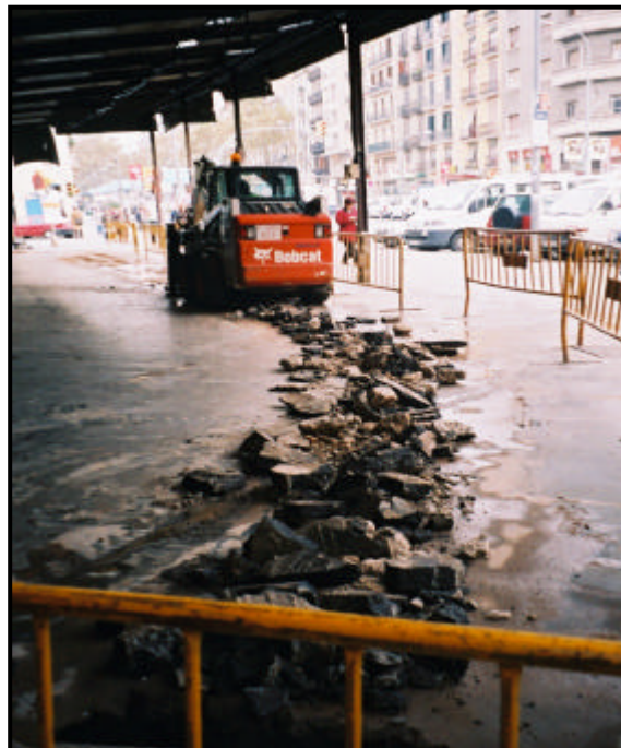
8. Obertura de Rasa 2 (UE 2000).
